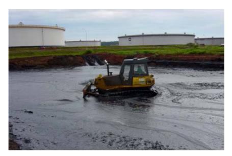
Figura 2.7 – Homogeneização da borra oleosa do *Landfarming* (REPLAN) para acondicionamento em tambores no pátio de resíduos para co-processamento.
