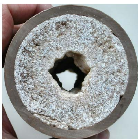
Figura 2.6: Incrustação carbonato de cálcio
