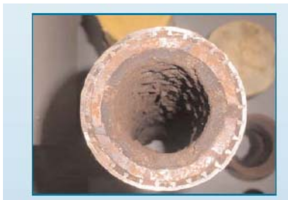
Figura 2.4: Incrustação Sulfato de Bário e Estrôncio
