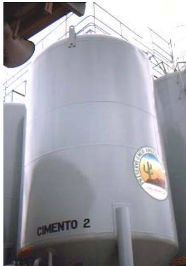
Figura 2: Silo de cimento
