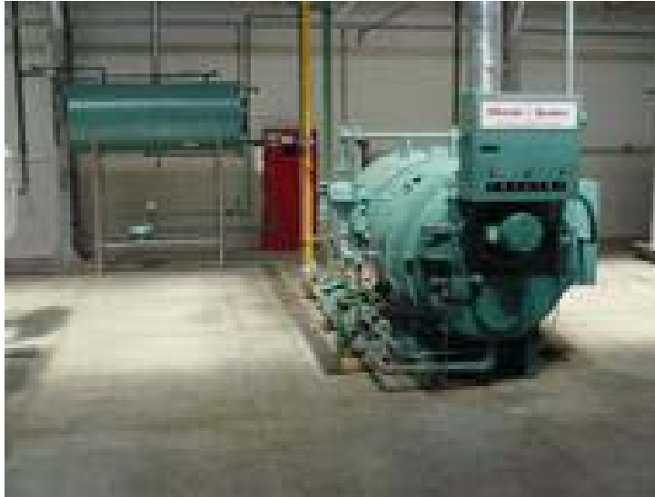
Figura 2.3: Caldeira a gás do tipo flamotubular
