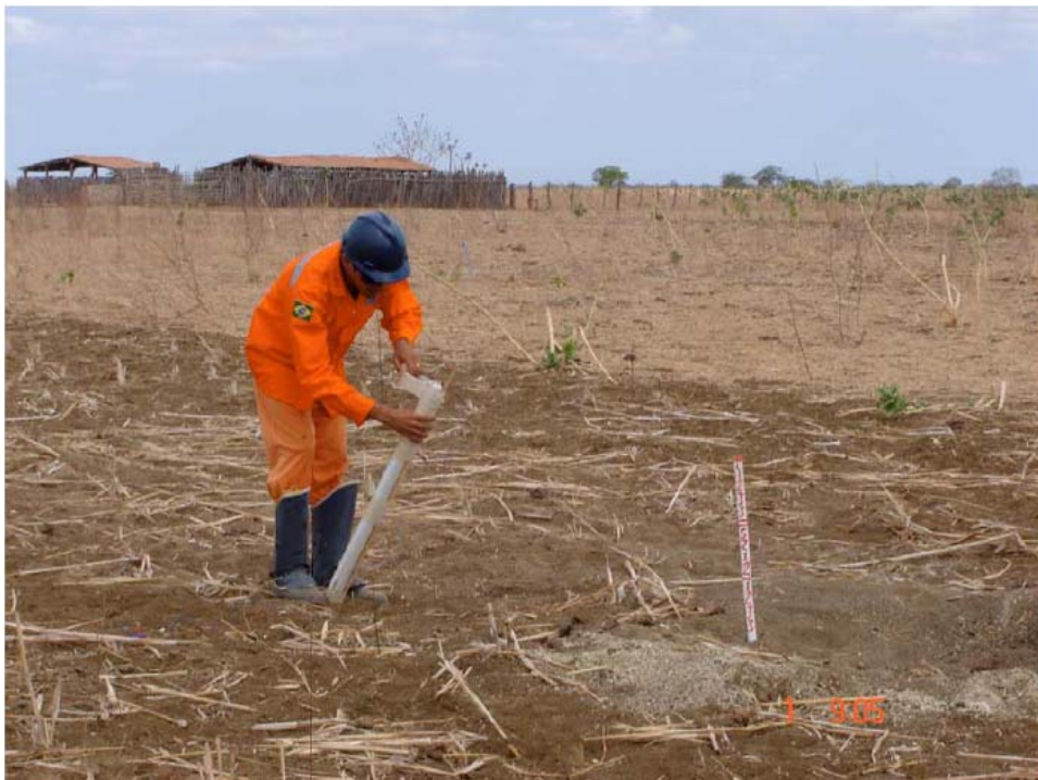
Figura 4.9. Carregamento de PT com carga de 2 kg de powergel.
