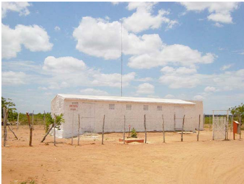
Figura 4.10. Depósito para explosivos com a capacidade de armazenamento de 26.000 kg de powergel e 15.000 m de cordel detonante.
