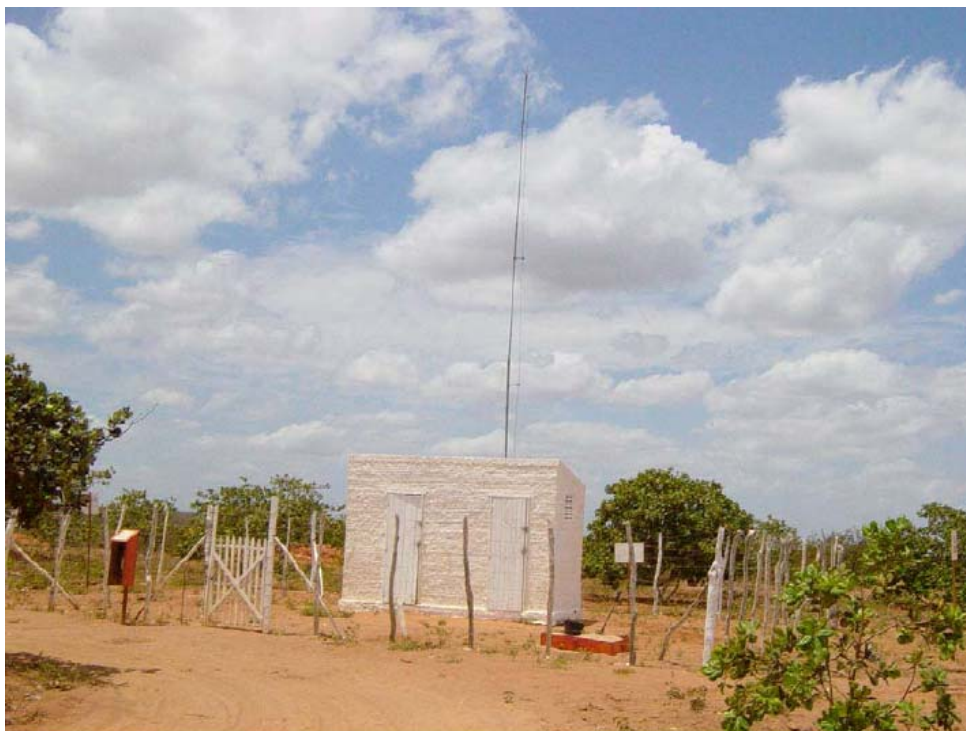
Figura 4.11. Depósito para espoletas elétricas com capacidade autorizada para 25.000 unidades.
