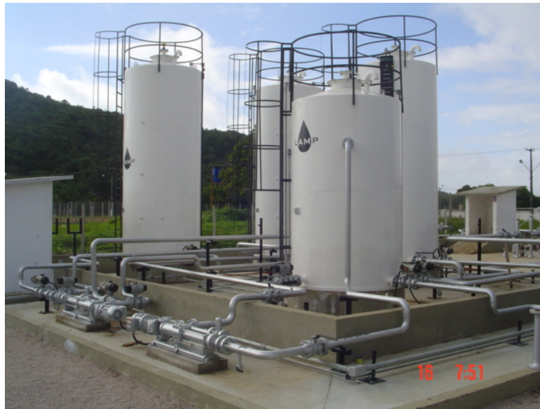
Figura 3 – Vista da bacia de contenção
