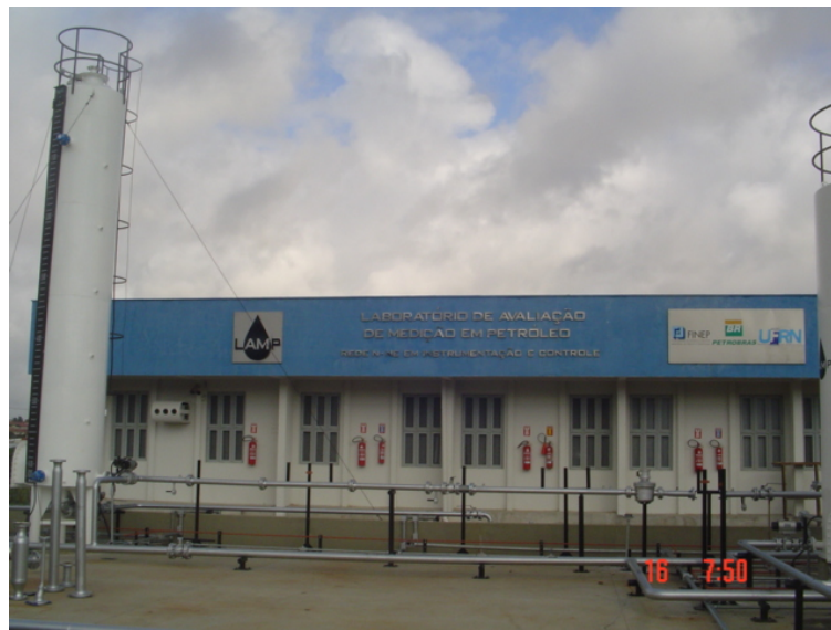
Figura 1 - Vista do laboratório de análise de medição em petróleo.
