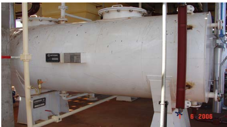
Figura 18. Primeiro decantador (DC-01).
