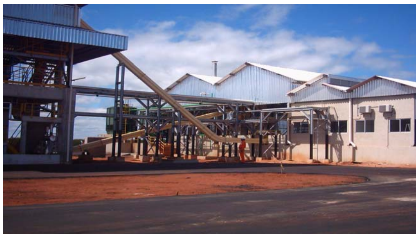
Figura 11. Transportador de correia (TC-02).
