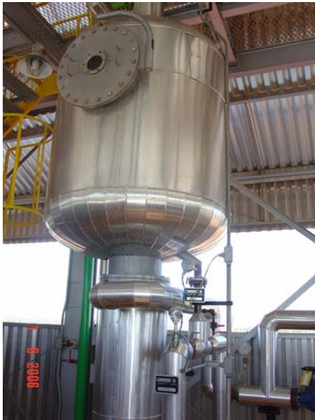
Figura 17. Primeiro evaporador (EV-01).
