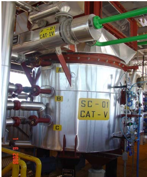
Figura 12. Secador de semente (SC-01).
