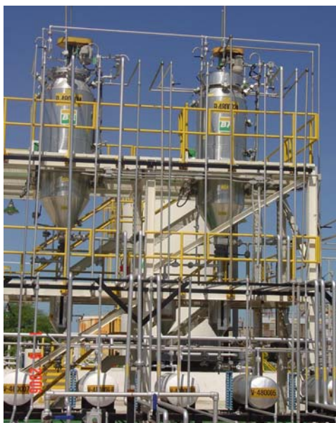
Figura 5. Reatores e decantadores utilizados para reação, lavagem e decantação
