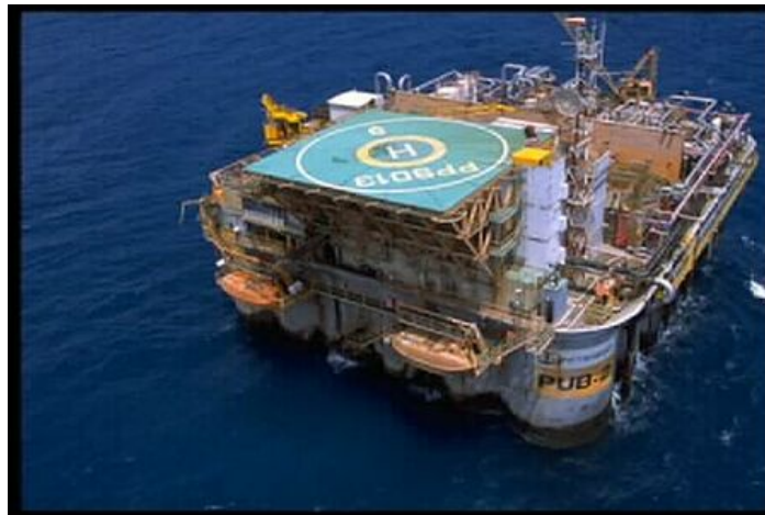
Figura 27. Plataforma de Ubarana 2
