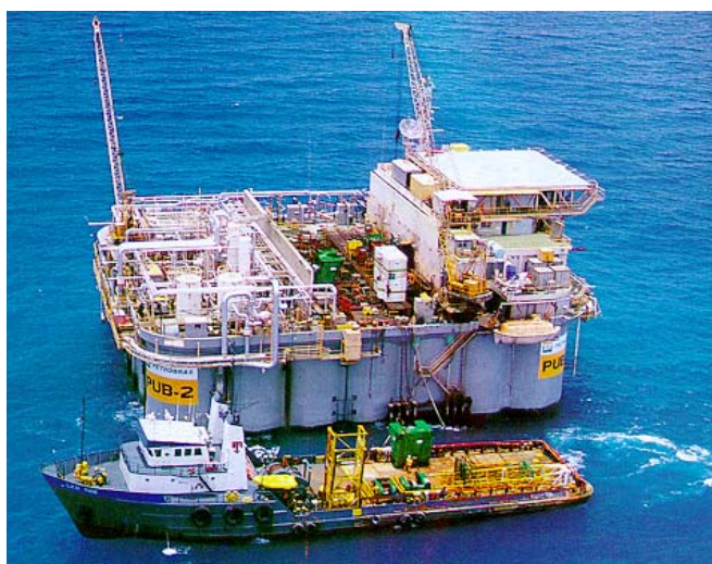
Figura 16- Plataforma de Ubarana 2 (PUB-02)
