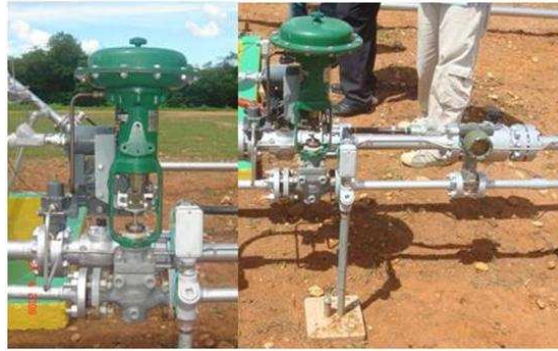
Figura 2.11: Válvula eletro-pneumática (Lorena – Mossoró/RN).
