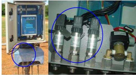
Figura 2.8: Transdutores pressão/corrente presente em campo (Lorena - Mossoró/RN).
