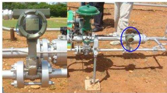
Figura 2.9: Sensor de vazão instalado na linha de injeção de gás (Lorena – Mossoró/RN).
