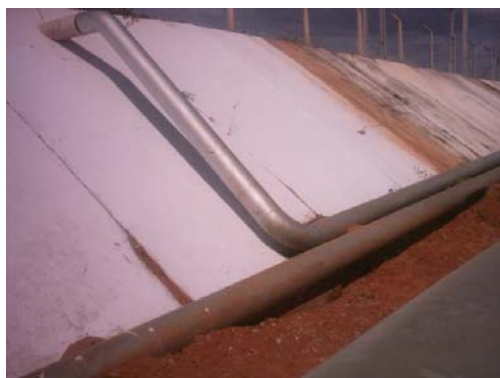
Figura 14 – Descarga das bombas do campo X1.
