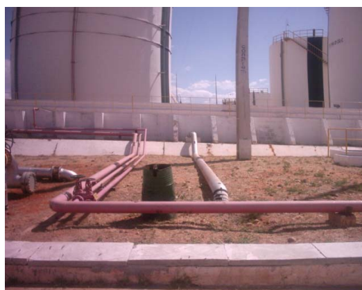
Figura 15– Linha proveniente de tanque.
