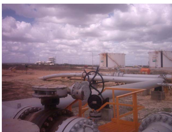
Figura 17 – Chegada dos oleodutos no pólo.
