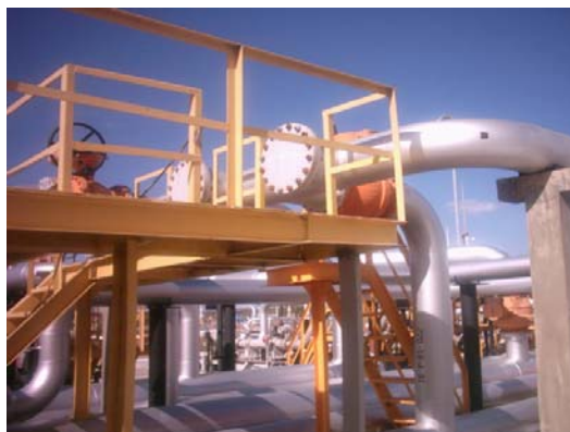
Figura 16 – Interligação das bombas em X2.
