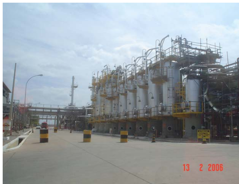
Figura 22 - Pólo industrial de Guamaré.
