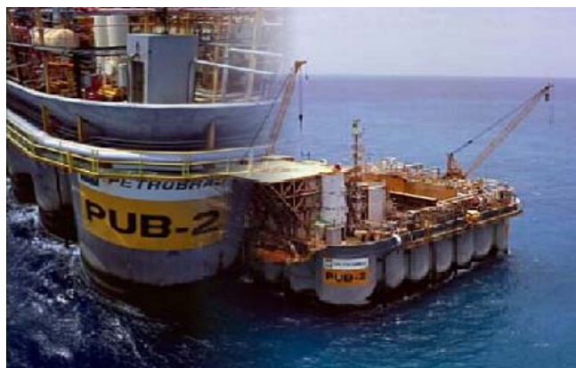
Figura 03- Foto aérea da Plataforma de Ubarana-PUB-2
