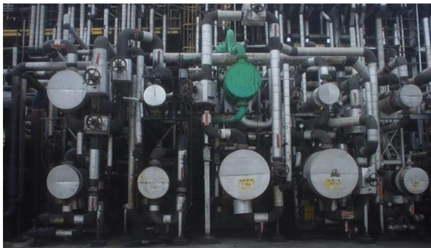
Figura 3.6 – Bateria de pré-aquecimento da U-9
