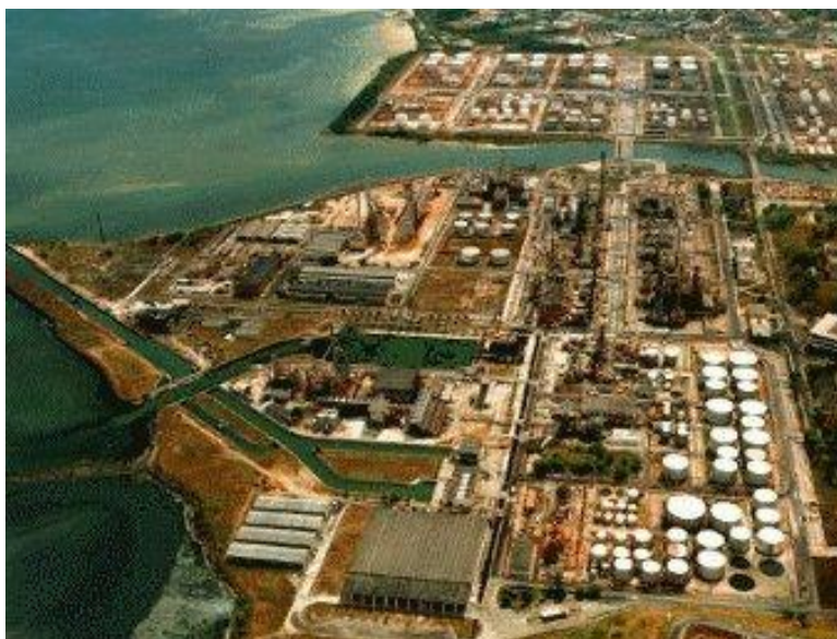
Figura 2.1 – Vista aérea da Refinaria
