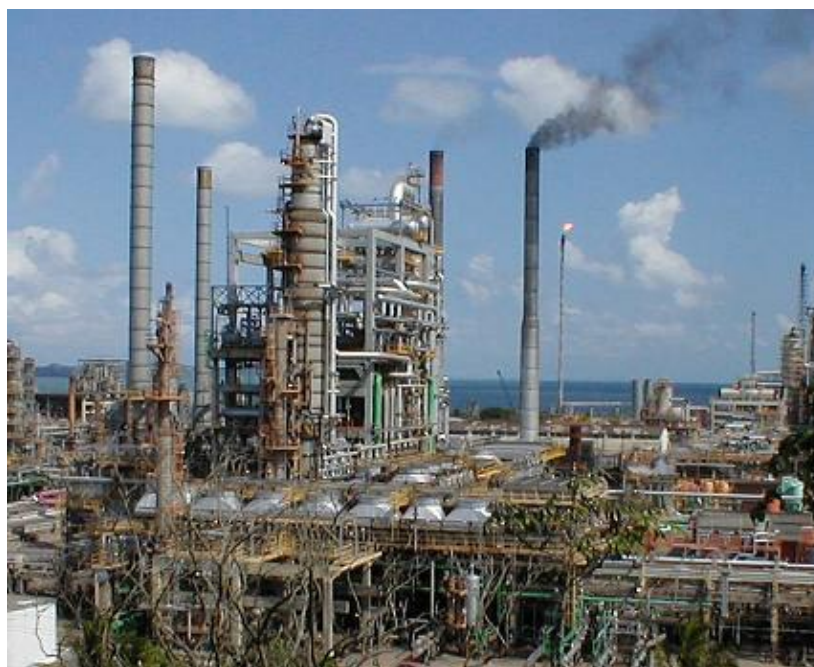
Figura 3.5 – Unidade - 9 de Destilação
