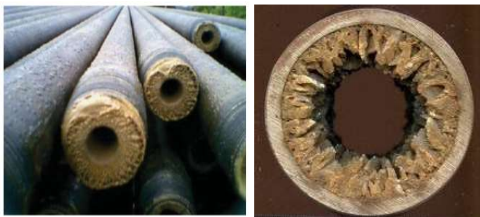
Figura 4 – Exemplos de incrustações em tubulações petrolíferas.
