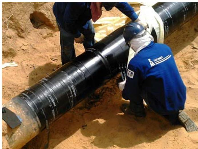
Figura 6 – Execução do revestimento no duto
