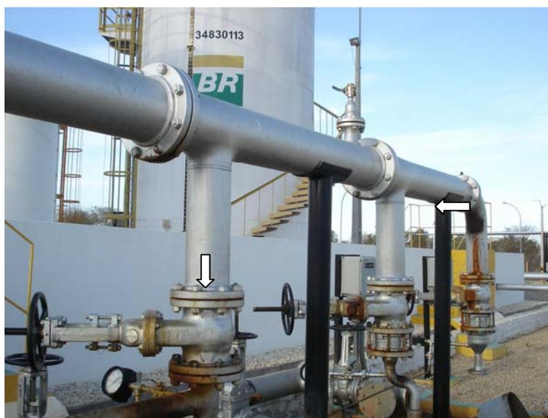
Figura 4 – Corrosão nos tubos
