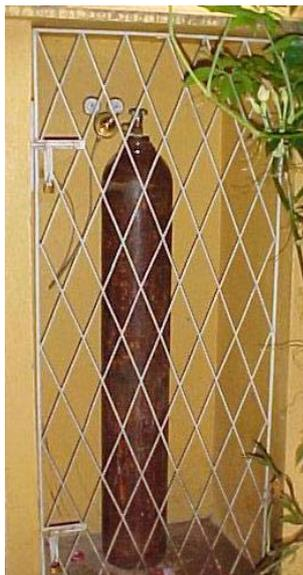
Figura 3 – Casa do cilindro de gás do LTC-UFRN.
