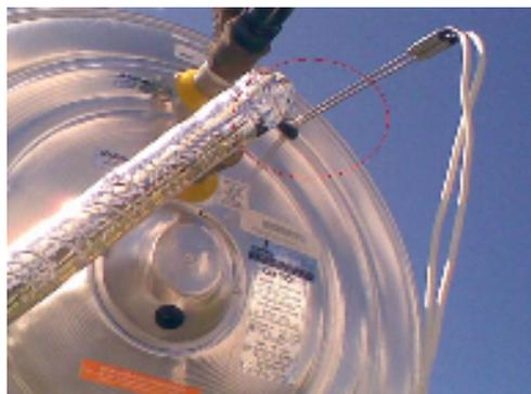
Figura 13. Detalhe do poço para termorresistência no boiler
