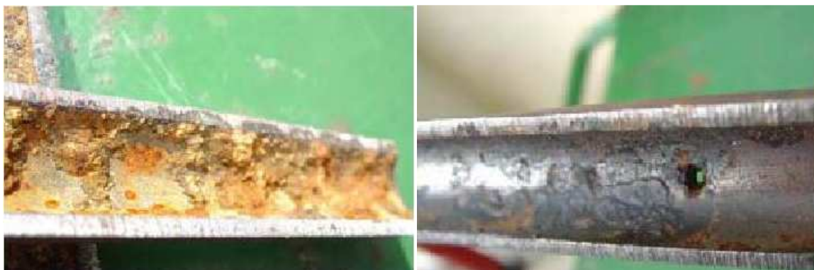
Figura 1. Efeitos da cavitação em dutos
