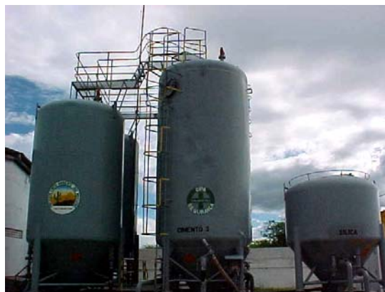
Figura 03: Silos de cimento e de sílica.
