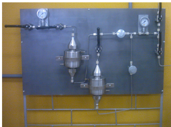
Figura 19. Vista do sistema de umidificação do gás natural.
