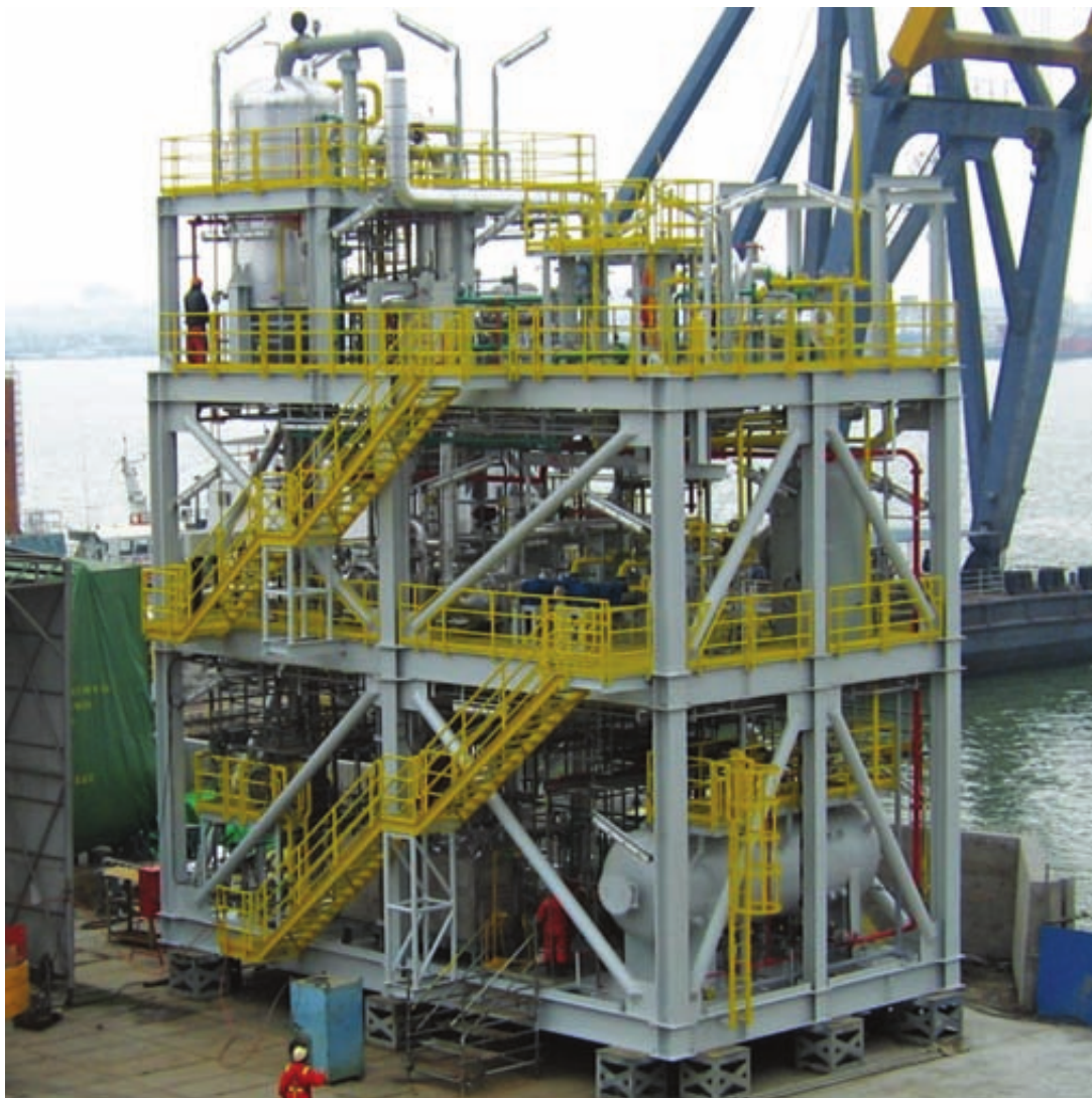
Figura 15 – Unidade de MEG utilizada na plataforma PMXL-1.
